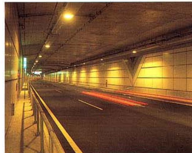
多摩川トンネル
