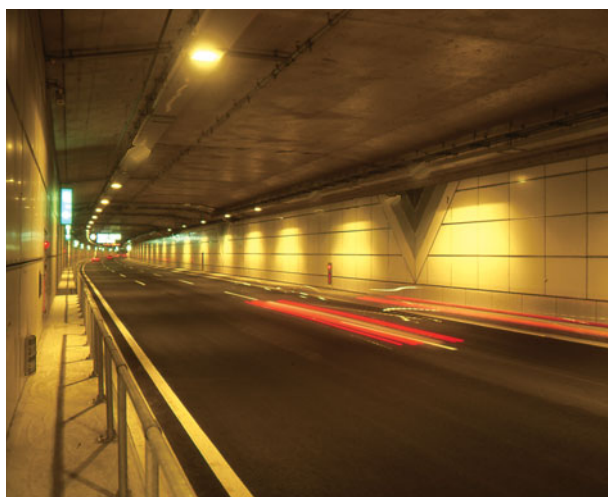
多摩川トンネル
